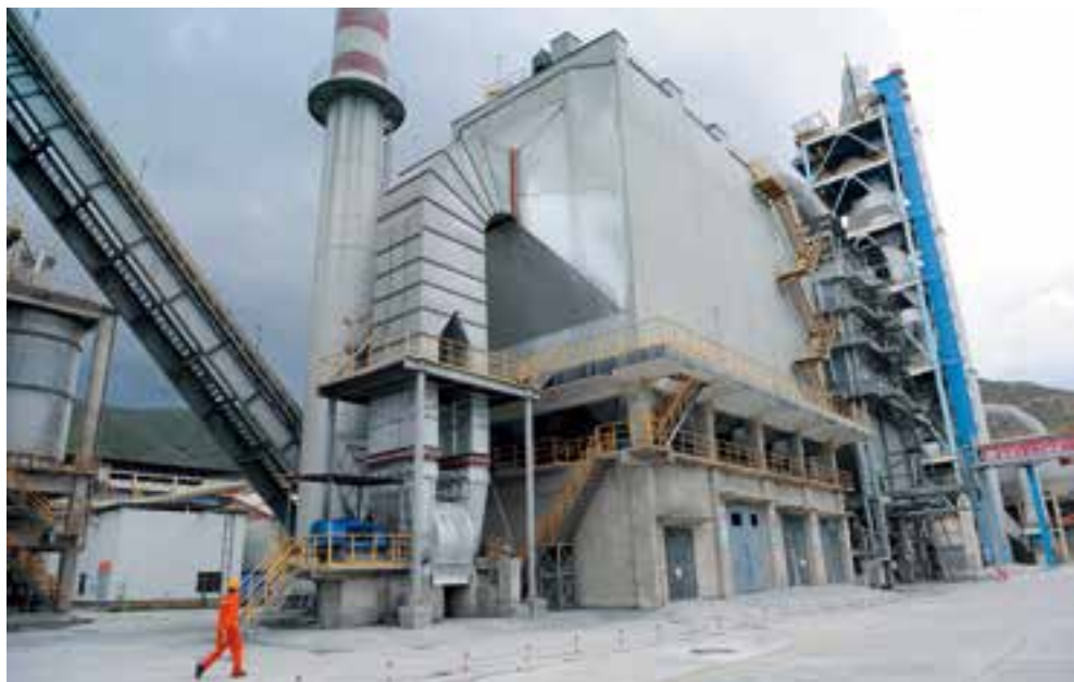
西藏工业实现了快速增长，图为西藏山南华新水泥厂。
