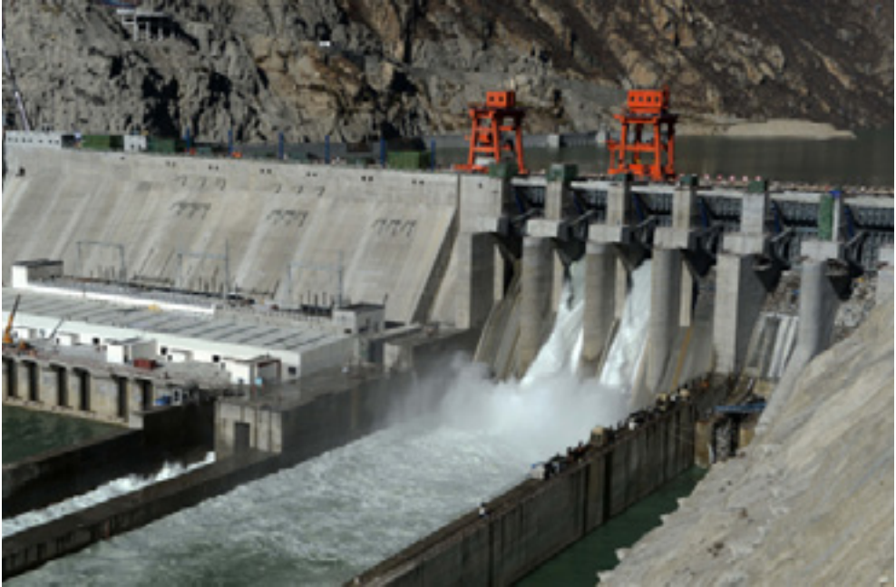
Le Tibet abonde en ressources hydrauliques. Sur la photo, la centrale hydroélectrique de Zam récemment construite.
