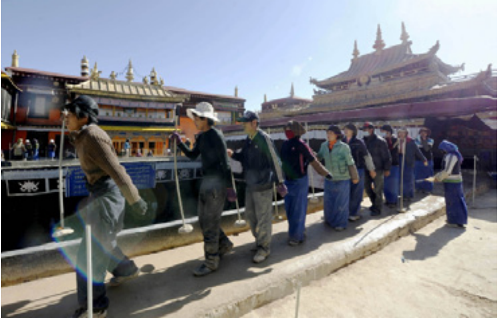
L'autorité centrale a affecté une somme importante aux travaux de restauration et de remise en état de sites tibétains. Sur la photo, le monastère de Jokhang en cours de restauration.
